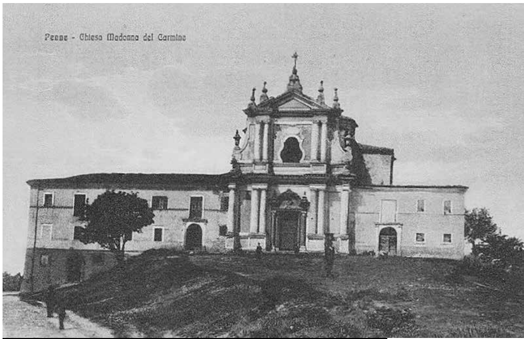
▲ Prospetto della chiesa del Carmine nel 1900
