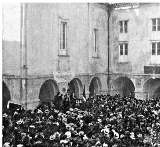
▲ Penne, 4 maggio 1914 - Comizio pro ferrovia Penne-Montesilvano tenuto in piazza dall'avv. Ottavio D'Angelosante. Ph. Archivio F. Mulciri
