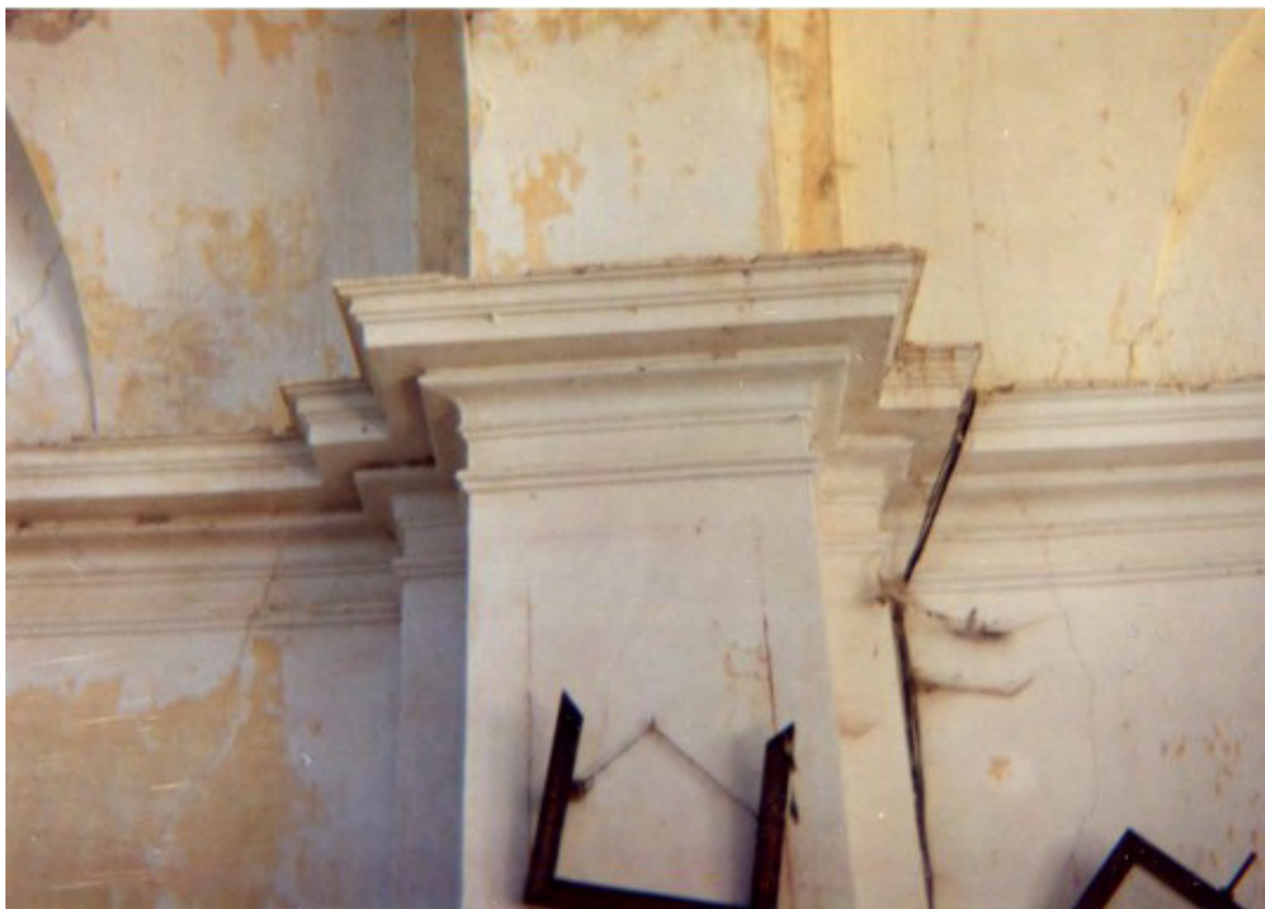
Particolare del cornicione interno.
