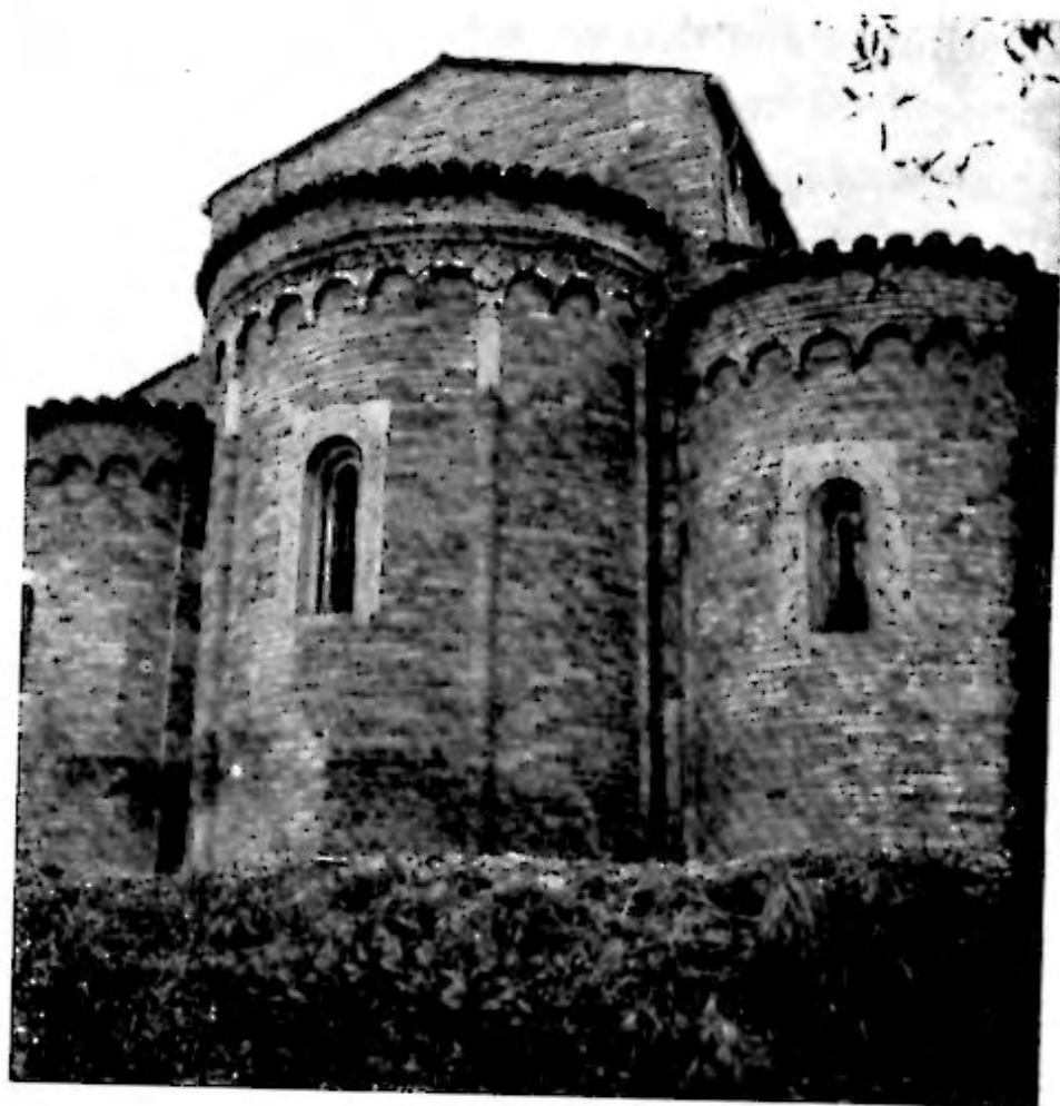
MOSCUFO Chiesa di S. Maria del Lago: veduta esterna dell'abside
