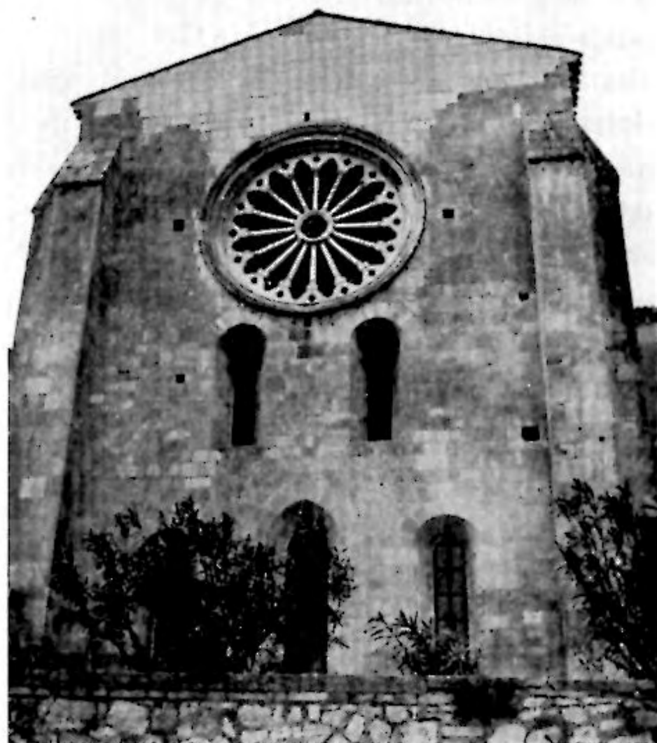
MANOPPELLO Chiesa di S. Maria Arabona: veduta esterna dell'abside centrale
