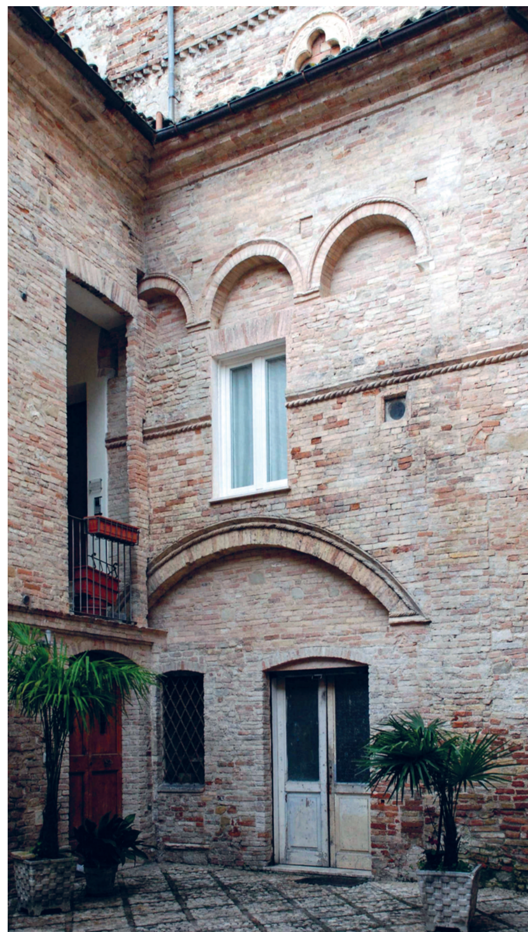
▲ Il cortile interno del palazzo De Flaminii
