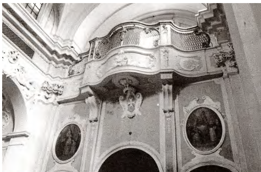
Cantoria. La grata lignea del parapetto è ancora integra. Foto Carlo Pilone. 1998.
