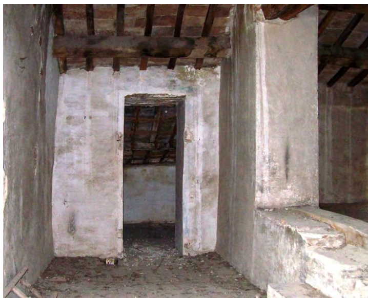
Chiesa di San Giovanni Battista. Locale del sottotetto con il vano che ospitava il Cristo di pezza. Sulla parete è visibile l'impronta della croce dell'ultima stazione della Via Crucis .
